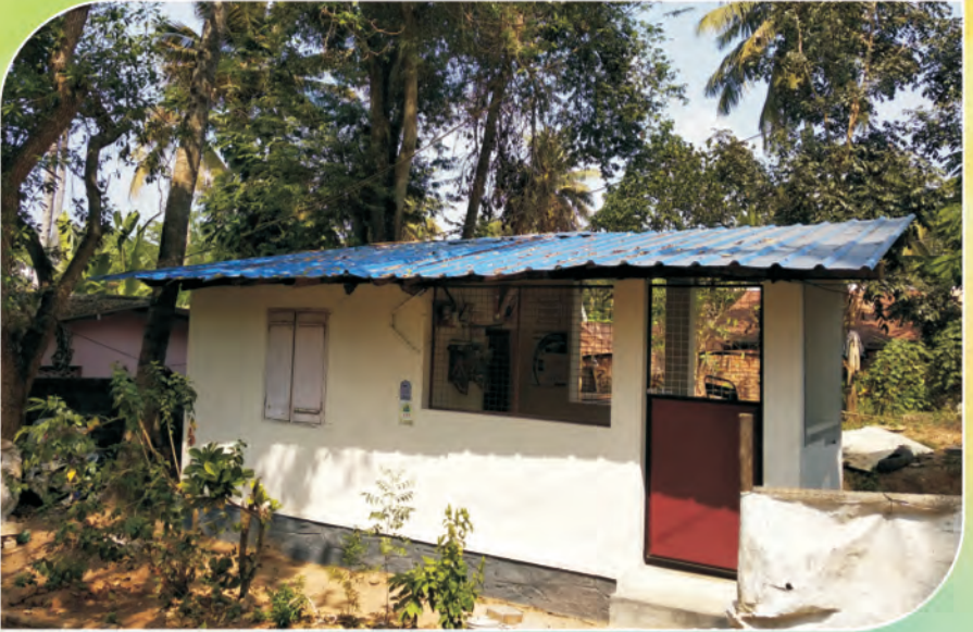
നമ്മുടെ സഭാംഗമായ മൈക്കിൾ പാപ്പച്ചന്റെ ഭവനം വാസയോഗ്യമാക്കി പുനർനിർമ്മിച്ചു നൽകി.
